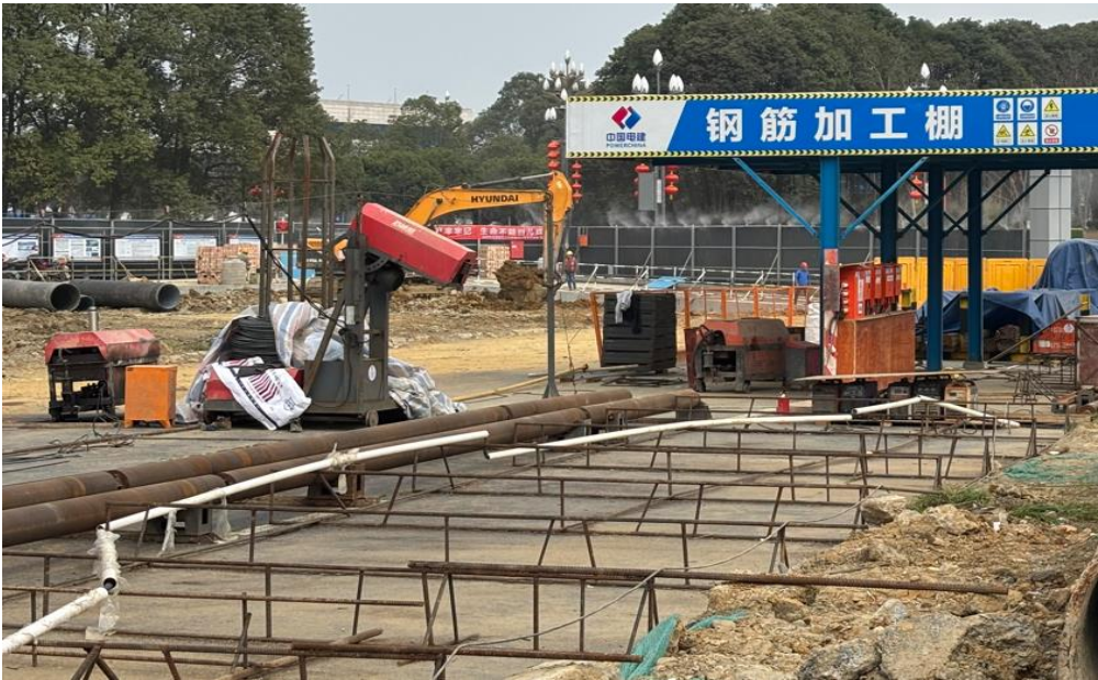
图 2.2-1 施工临时场地照片（加工区）
