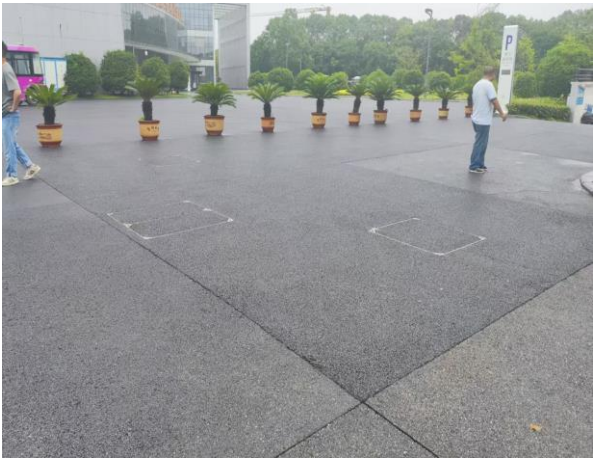
图 2.4-1 项目建设区原状照片（一）
